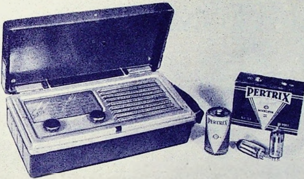
Bild 1. Metz „Baby“, der kleine, leichte und elegante Reiseempfänger gehört zu den besten Nachkriegskonstruktionen der deutschen Radioindustrie. Das Gerät in der Größe eines Zigarrenkistchens wiegt nur 1,8 kg einschl. Batterien
